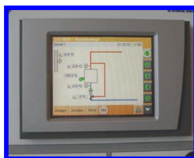
DDC-Originalregler mit Browserfähiger Bedienoberfläche und Serviceebene
